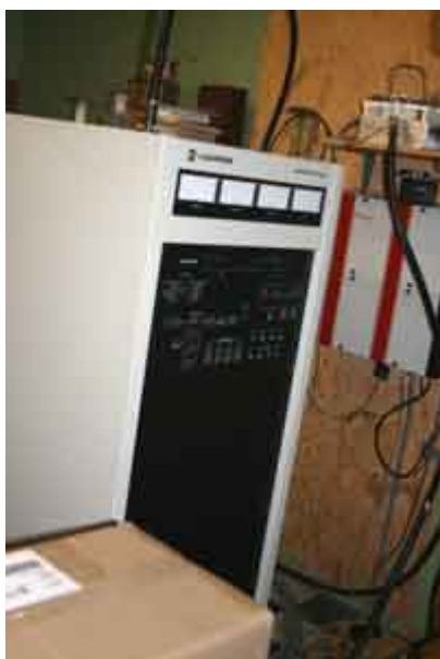
5 kW Harris-sändare hos WMSR. Nattetid sänks effekten till 79 W!
