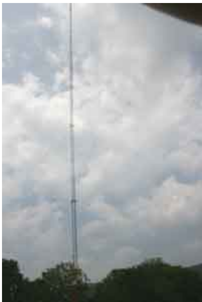
En övergiven antennmast i Jasper, Tennessee
