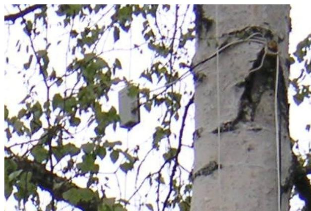
man se plastboxen som innehåller relä, balun och avslutningsmotstånd. En koaxkabel och signalkabel går ner till marknivå längs stammen. Den horisontella tråd som ses ligger ca 3-3,5m ovanför marknivå.
